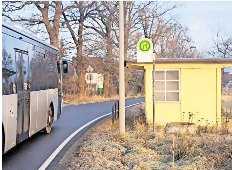
Das Bushäuschen in Brehmenhain an der Kreuzung. Die Stadt Rothenburg will diesen DDR-Bau abreißen und eine neue Bushaltestelle mit Unterstand weiter im Ort errichten.
